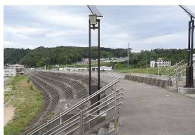
田老の第一防浪堤 令和5年5月31日撮影 昭和8年三陸大津波の翌年から建設。吉村は「堤は厚く、弧をえがいて海岸を長々とふかどっている。防浪堤について「町民の努力の結果なのだろうが、それは壮大な景観であった」と記した(注)。防浪堤は東日本大震災後に整備されている。
